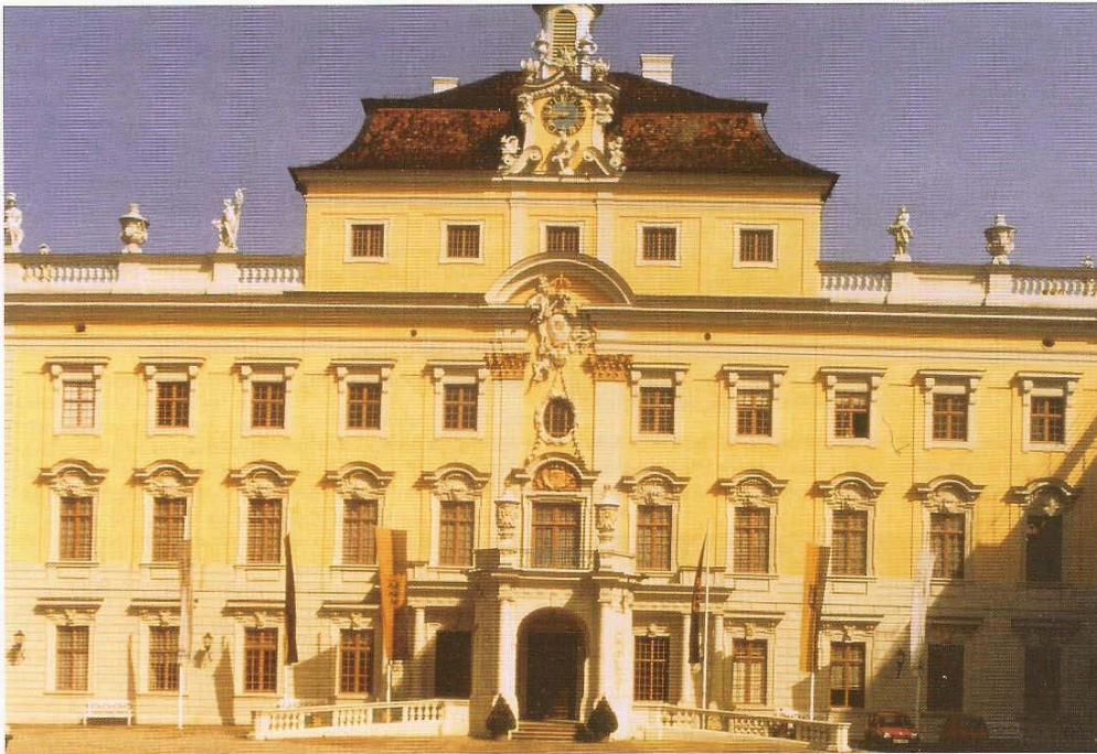
Ein Teil der mit dem Restaurierungsmörtel sanierten Fassade wurde bereits abgerüstet und strahlt jetzt wieder in historischer Zweifarbigkeit in Grau und Gelb.
